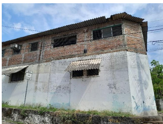
Vista de Fachada oeste, (fachada posterior)
