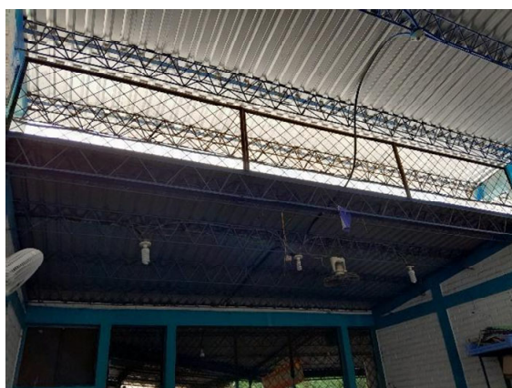
Ventana cenital en aulas del módulo A
