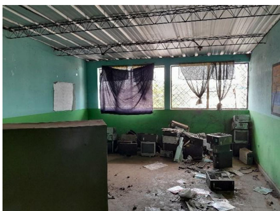
Vista interna de aulas en módulo B1 (segundo nivel)
