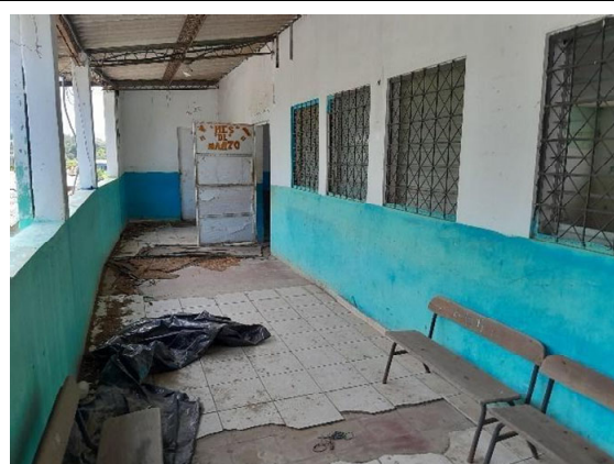
Vista de módulo de aulas B (Segundo nivel)
